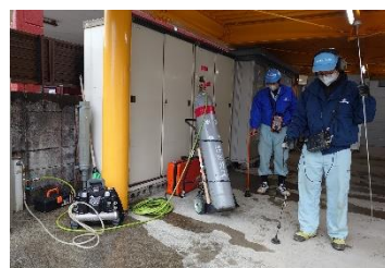
漏水調査の様子
