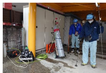
漏水調査の様子
