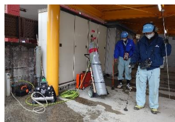
漏水調査の様子
