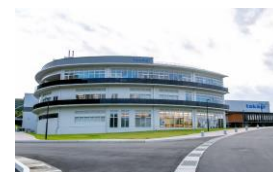
(株)タカギの新本社工場
