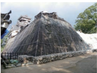
熊本震災の石垣防護網（熊本城復旧）
