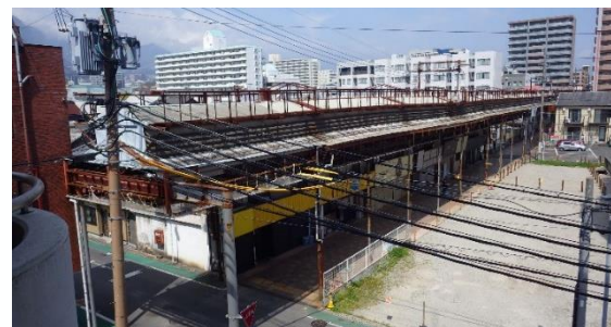
整備前の写真
