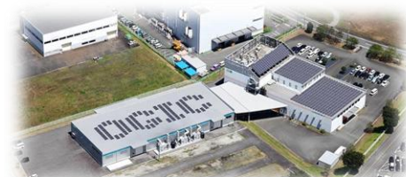
ソーラーパネル (計150 kW)
