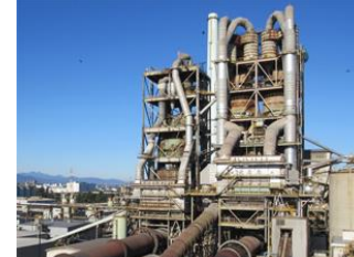
セメント製造業
