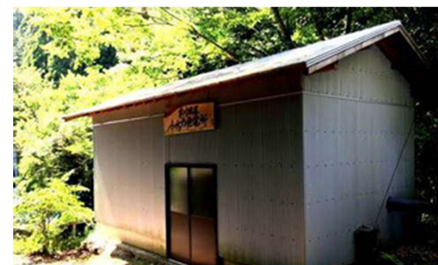
▲発電施設の外観／出所：水俣市
