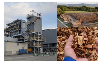
◀さつま町バイオマス 発電所(1,990kW) ／出所：さつま町バイ オマス発電合同会社
