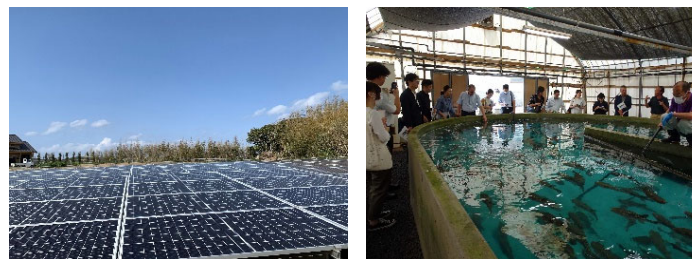
▲陸上養殖場に隣接した太陽光発電設備 ／出所：壱岐市
