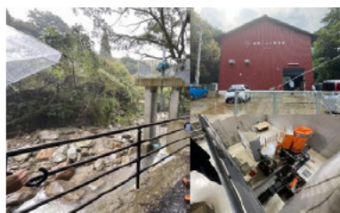
◀泊野川水力発電所 (530kW) ／出所：みずいろ電力 株式会社
