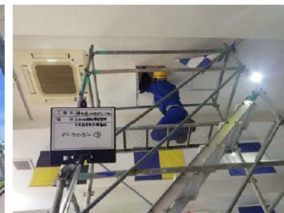
写真左側：博多港ベイサイドミュージアム、右側：効果検証用温度測定器取り付け写真
