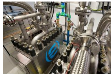
水素製造装置
