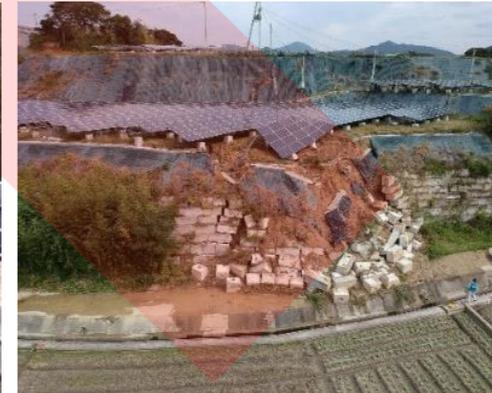
法面保護工が崩れて流出した事例
