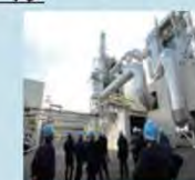
バイオマス発電所
