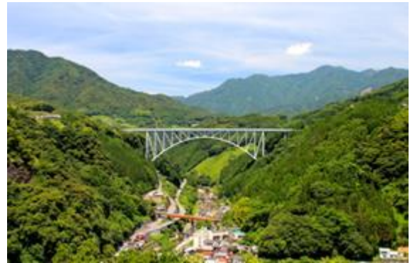
写真：「青雲橋」外観
