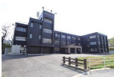
A I 研究開発施設外観
