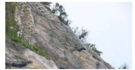
【福岡地震志賀島復旧工事】
