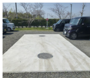
耐震性貯水槽
