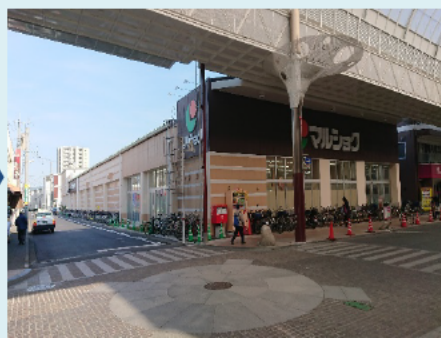
改修されたアーケード
