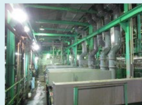
復旧後の工場
