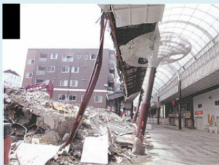
被災したアーケード
