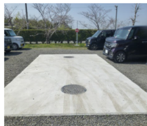
耐震性貯水槽
