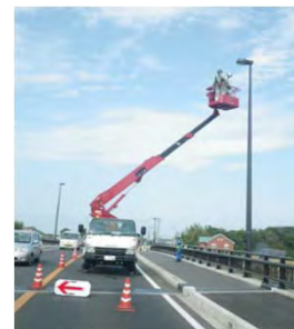
(従来) 高所作業車による点検
