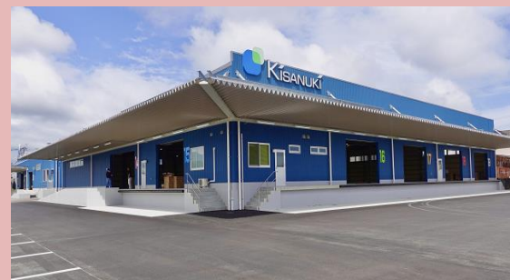
補助金を活用して竣工した工場（キサヌキ）
