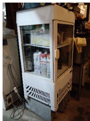
冷蔵庫の下にブロックを設置
