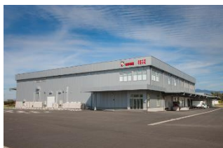
本社工場の外観
