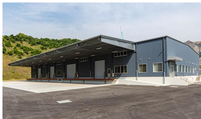
新倉庫の外観
