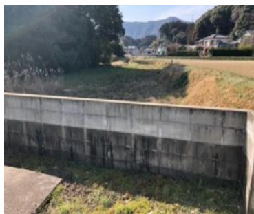
ブロック塀増設（白部分）
