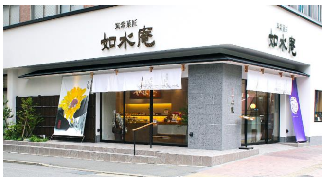
博多駅前本店の外観
