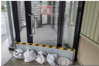
止水板を設置している様子 台風10号上陸の際にも活躍した
