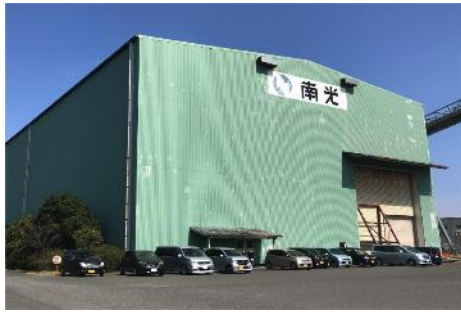
本社第一工場
