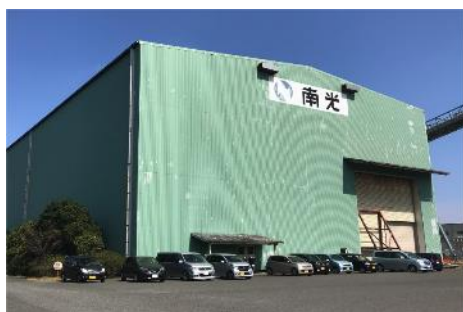
本社第一工場
