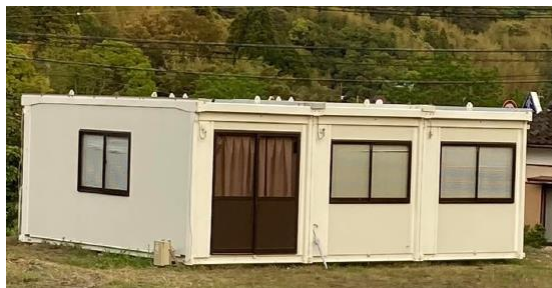
コロナ時に一時的に建てた仮設事務所
