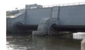
コンクリート構造物補修・補強
