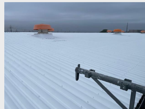
遮熱塗装を実施した工場折版屋根
