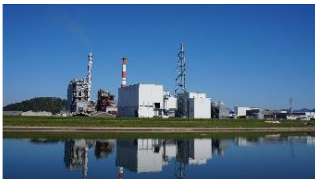
木質バイオマス発電設備
