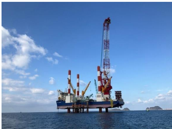
SEP 船を活用した洋上での風車組立
