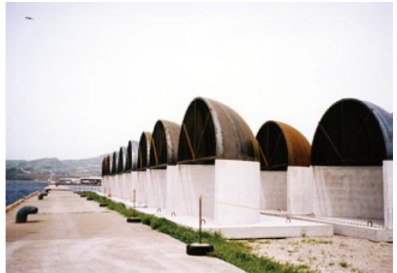
流況制御ブロック
