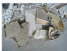
家屋の解体時に出る破材
