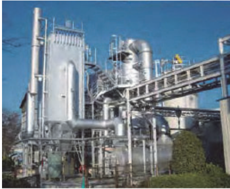
流動床式バイオマスボイラー
