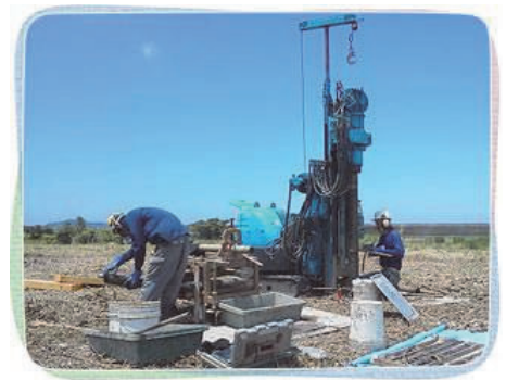
土壌調査状況
