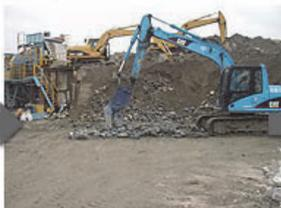
大きなガラを人頭程度の大きさへ割り、機械へ投入していきます。
