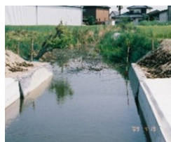
試験施工完了後(奥側、約2ヶ月後)
