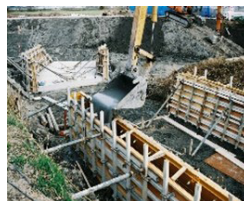
ジオポリマー擁壁の試験施工状況
