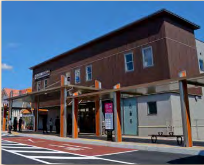
田辺市観光センター 外観 (写真提供：田辺市熊野ツーリズムビューロー)
