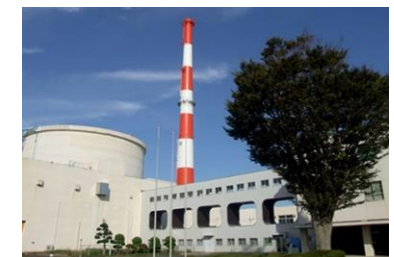
高速実験炉「常陽」
