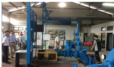
インドネシア工場の様子
