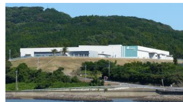
公司成立地長崎縣松浦市的FI工廠。利用最新設備製造屋頂材料
