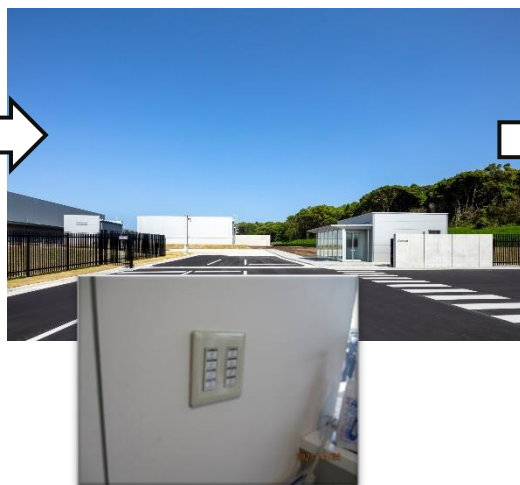
警備室に手元SWを設置 照明の制御を変更
