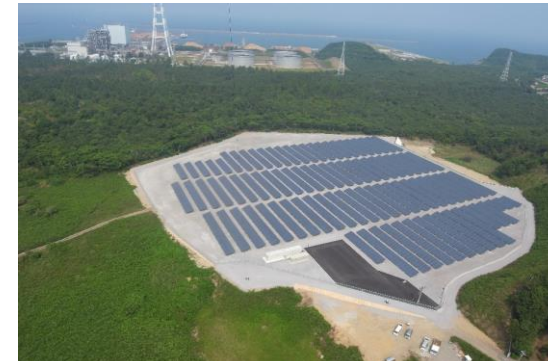
メガソーラー発電設備
