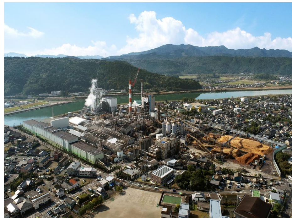
川内工場全景
