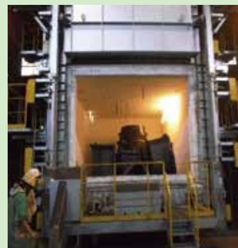
炉に火入れした様子
