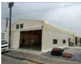
北九州エコタウン 地域循環圏リサイクルセンター
